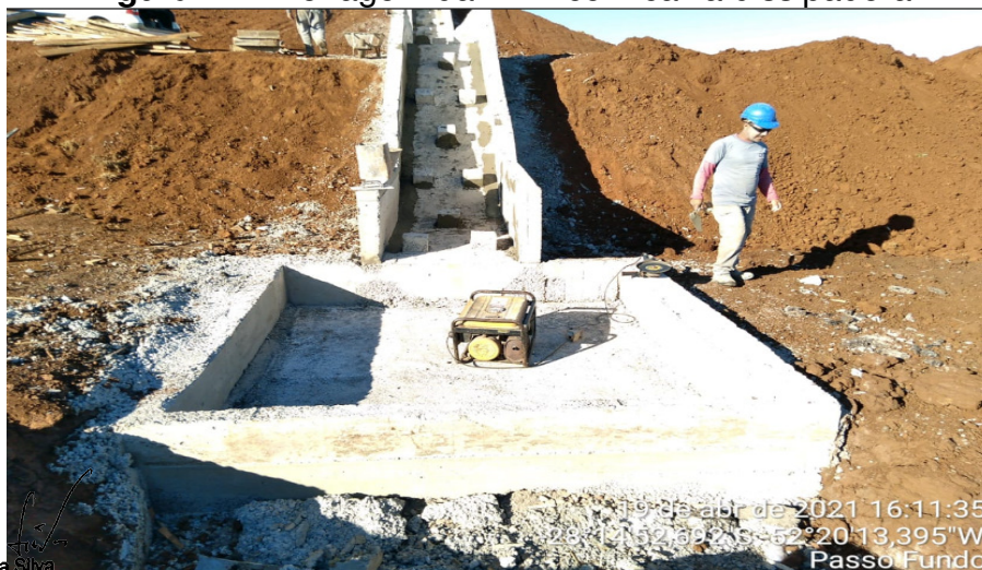
Figura 17: Drenagem da PPD com caixa dissipadora
