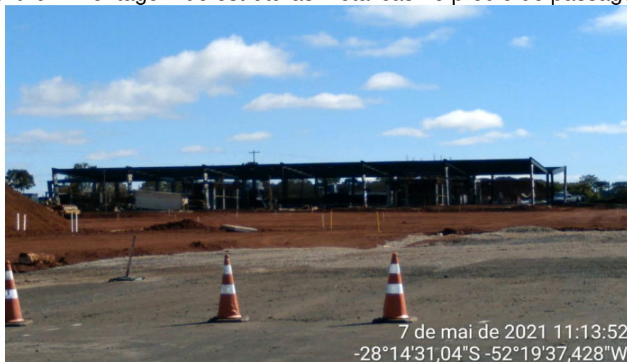
Figura 07: Montagem de estruturas metálicas no prédio de passageiros.
