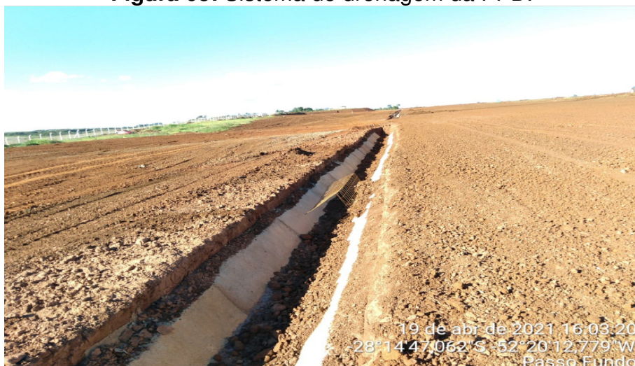
Figura 05: Sistema de drenagem da PPD.
