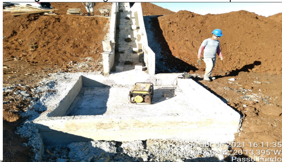
Figura 06: Drenagem da PPD com caixa dissipadora
